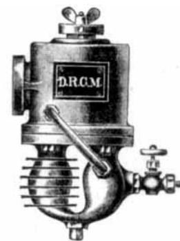
die Wasseroberfläche tropft und nicht an der Kesselwand entlang läuft. Der „T. V. G. Automat“ wird einmal wöchentlich je nach der Größe des Kessels und der Beschaffenheit des Wassers mit 2—10 kg Barytin oder calcinierter Soda gefüllt und bleibt dann sich selbst überlassen. Seine Wirkungsweise soll eine sehr gute sein.
